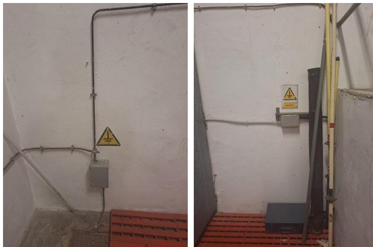
Fotografies 1 i 2.- Caixa de seccionament i comprovació de posta a terra xarxa de ferratges i xarxa de servei a mantenir.
