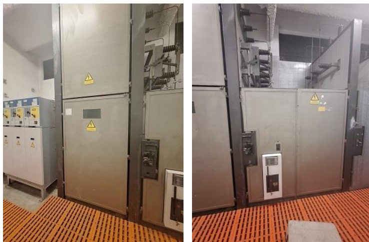
Fotografies 6 i 7.- Defenses metàl·liques a retirar així com interior corresponent a cel·la de mesura i de protecció automàtica
