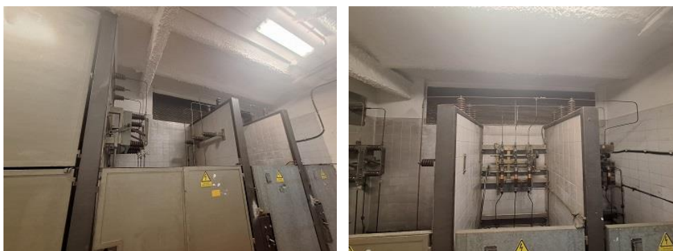
Fotografies 4 i 5.- aparells al aire i conductor amb cilindre rígid de coure nu a retirar
